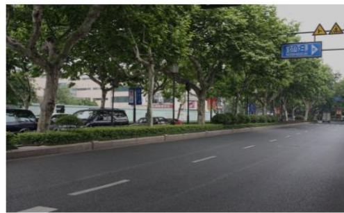
杭州保俶路综合整治工程
